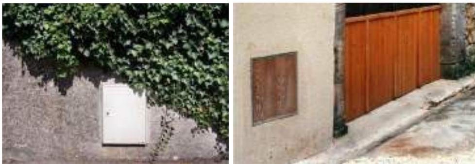
Repérage de réseaux et robinets de réseaux par bornes ou plaques:
