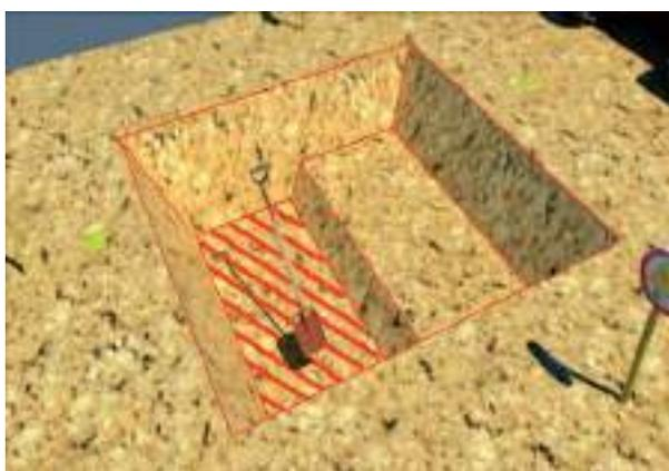
Terrassement manuel d'une tranchée de 30 à 40 cm de profondeur environ, perpendiculaire à l'ouvrage, avec vérification de sa profondeur (longueur de tranchée manuelle > largeur du godet)
