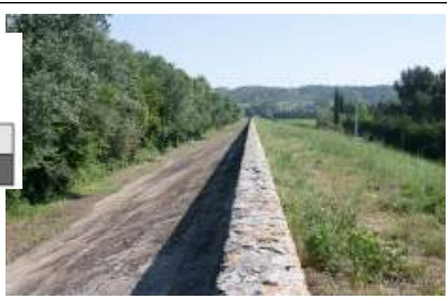
Les déversoirs sont des digues de structure particulière, permettant une surverse sans dommage pour l'ouvrage. Ils en font donc intégralement partie.
