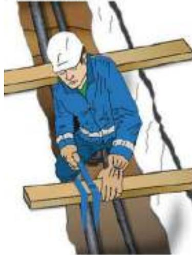
Si le câble est trop vétuste, le maintenir au moyen d'une gouttière ou d'une attelle. On peut, alors, procéder au soutènement de l'ensemble.
