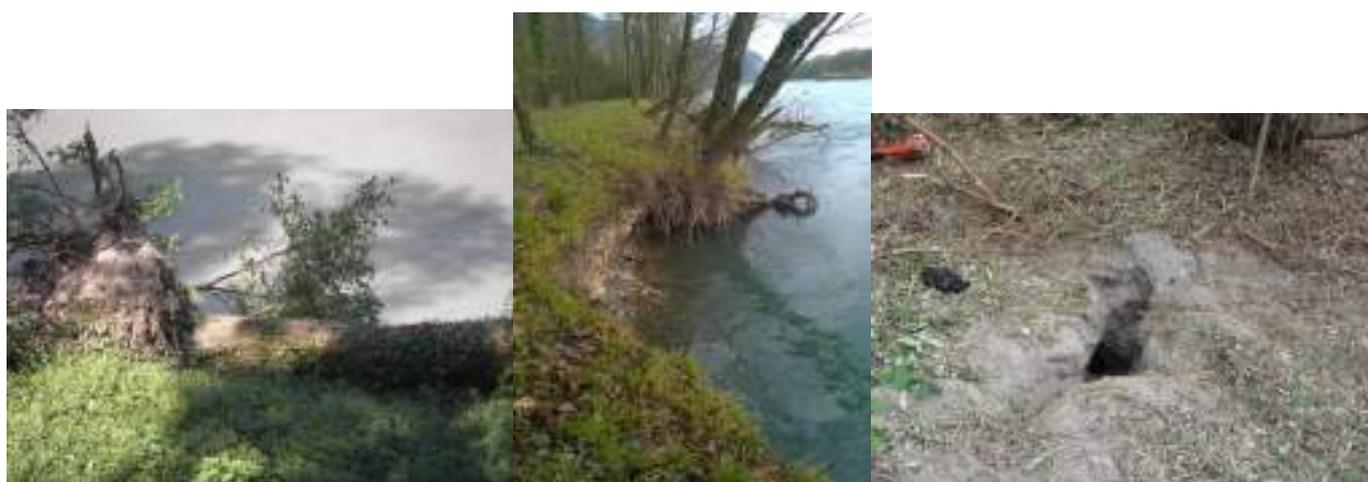
Figure 2 : Exemples de dommages sur digues, dus à la nature (chute d'arbre avec racine, anse d'érosion, terriers de blaireaux)
