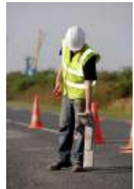
Le mode actif (raccordement direct sur l'ouvrage ou utilisation d'une pince à champs magnétiques ou tore) est performant et précis. Il permet de suivre une canalisation particulière et d'en connaître la profondeur.
