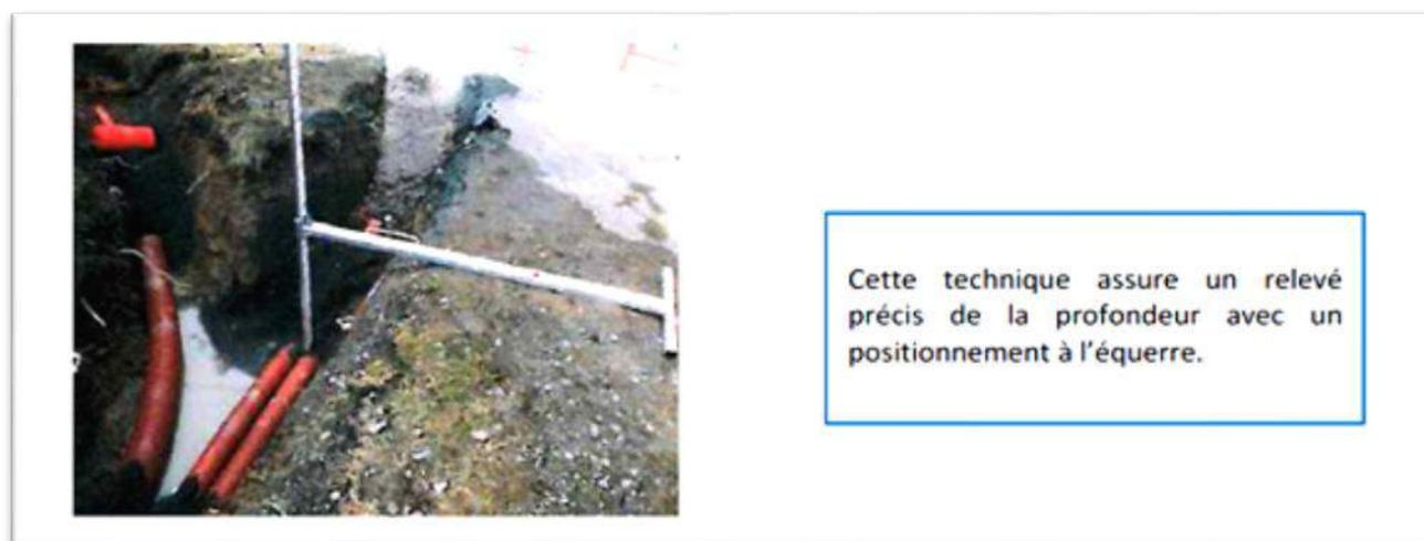
2 – En complément : sur les plans minutes, il faut indiquer les clous ou piquets avec leur numérotation correspondante (grâce aux rondelles gravées) aux photos prises pour les profondeurs.
